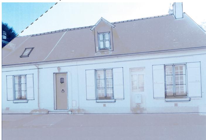
◀ Photo de l'existant avec calque au-dessus sur lequel la façade est redessinée avec la projection des travaux.
